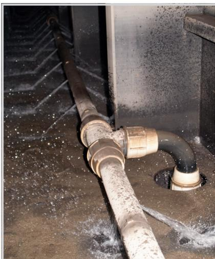
▲ Die Rohrleitungen verfügen über seitlich angebrachte Düsen. Mit ca. 1,5 bar Druck wird die Schlick-Rückspülung vorgenommen.
